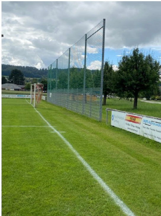
Ballfänger Nordseite, ersetzt
