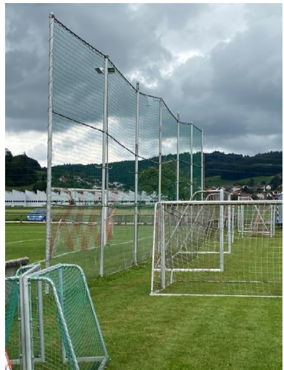
Ballfänger Südseite, zu ersetzen
